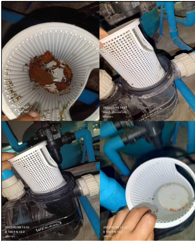
ภาคผนวกที่ 3.41 จัดให้มีเจ้าหน้าที่ตรวจสอบและทำความสะอาดระบบกรองสระว่ายน้ำ
